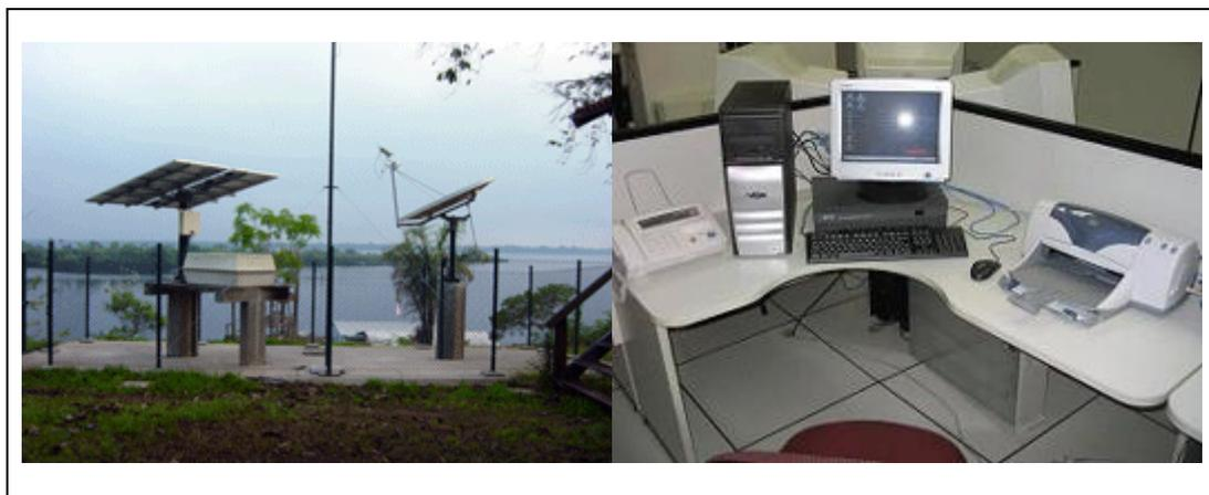
Figura 42 – Antena de comunicação via satélite, unidade de apoio incluindo painel para fornecimento de energia por fonte solar e um Terminal de Usuário.
